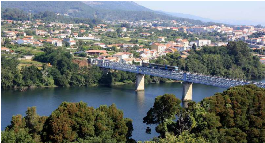
, PUENTE INTERNACIONAL EN TUI
