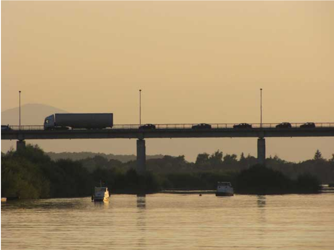
Puente-frontera sobre el río Sava
