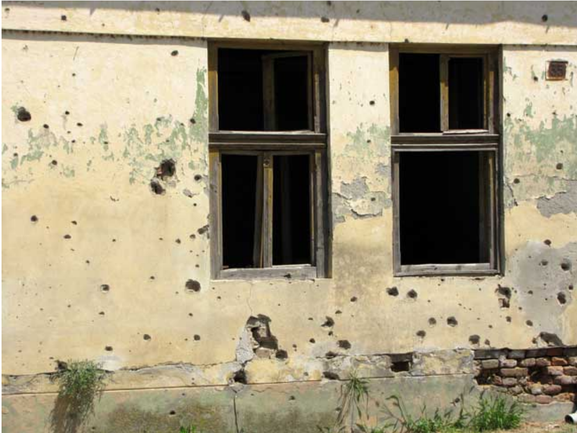
Casa destruida en Šarengrad
