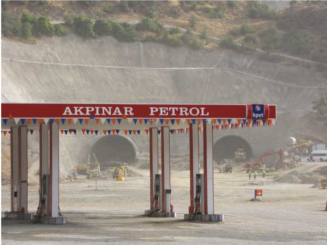
La gasolinera y los túneles
