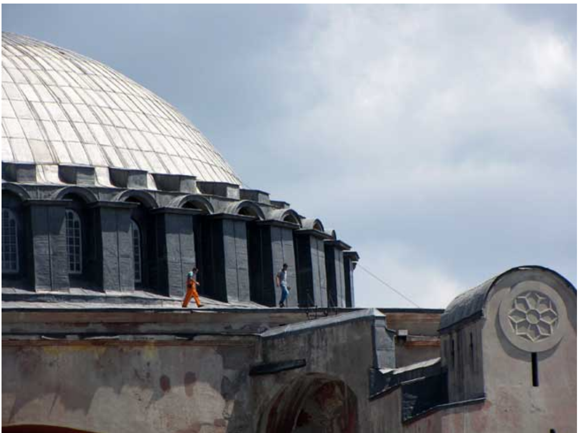
Se arreglan goteras
