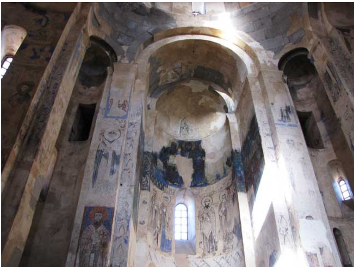
Interior del templo
