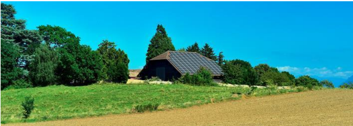
(Tejado cubierto de placas solares. Foto David)
