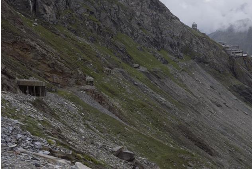
(Túneles en Gamsgrubenweg, Franz Joseph Höhe, foto David)
