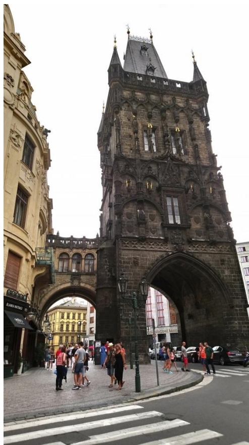
Torre de la pólvora, Praga
