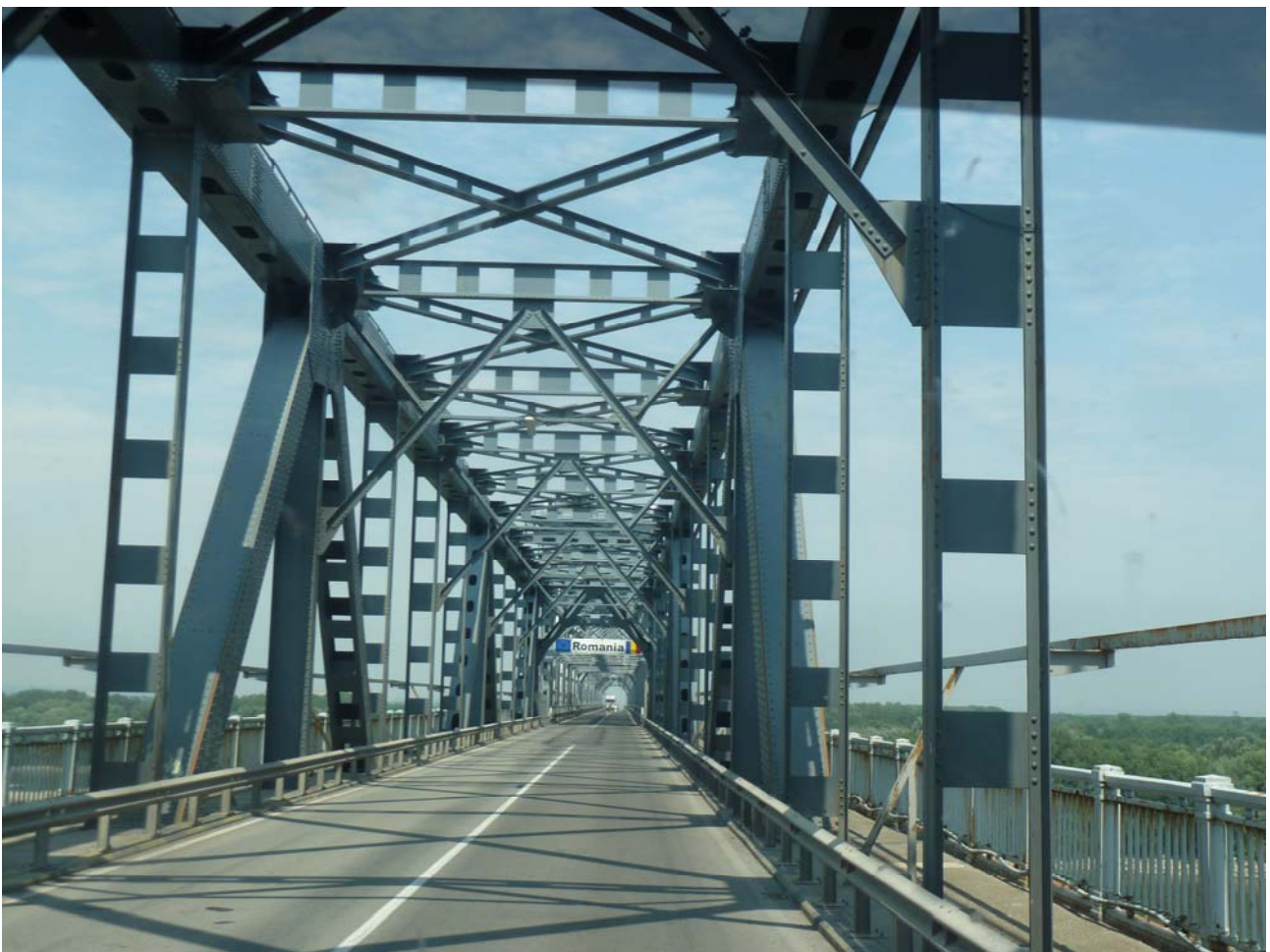
Puente sobre el Danubio
