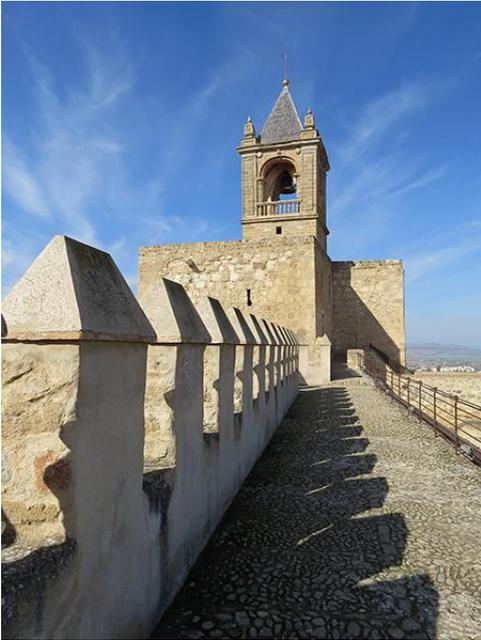
La Torre Blanca, unida a la anterior por un lienzo de murallas reforzado por dos contrafuertes, sorprende por la perfecta ejecución de su fábrica de sillería. Tiene dos plantas sobre la altura del adarve y sus diferentes estancias se cubren con distintos tipos de bóveda de ladrillo. El interior se ilumina con troneras y ventanas en arco de herradura.
