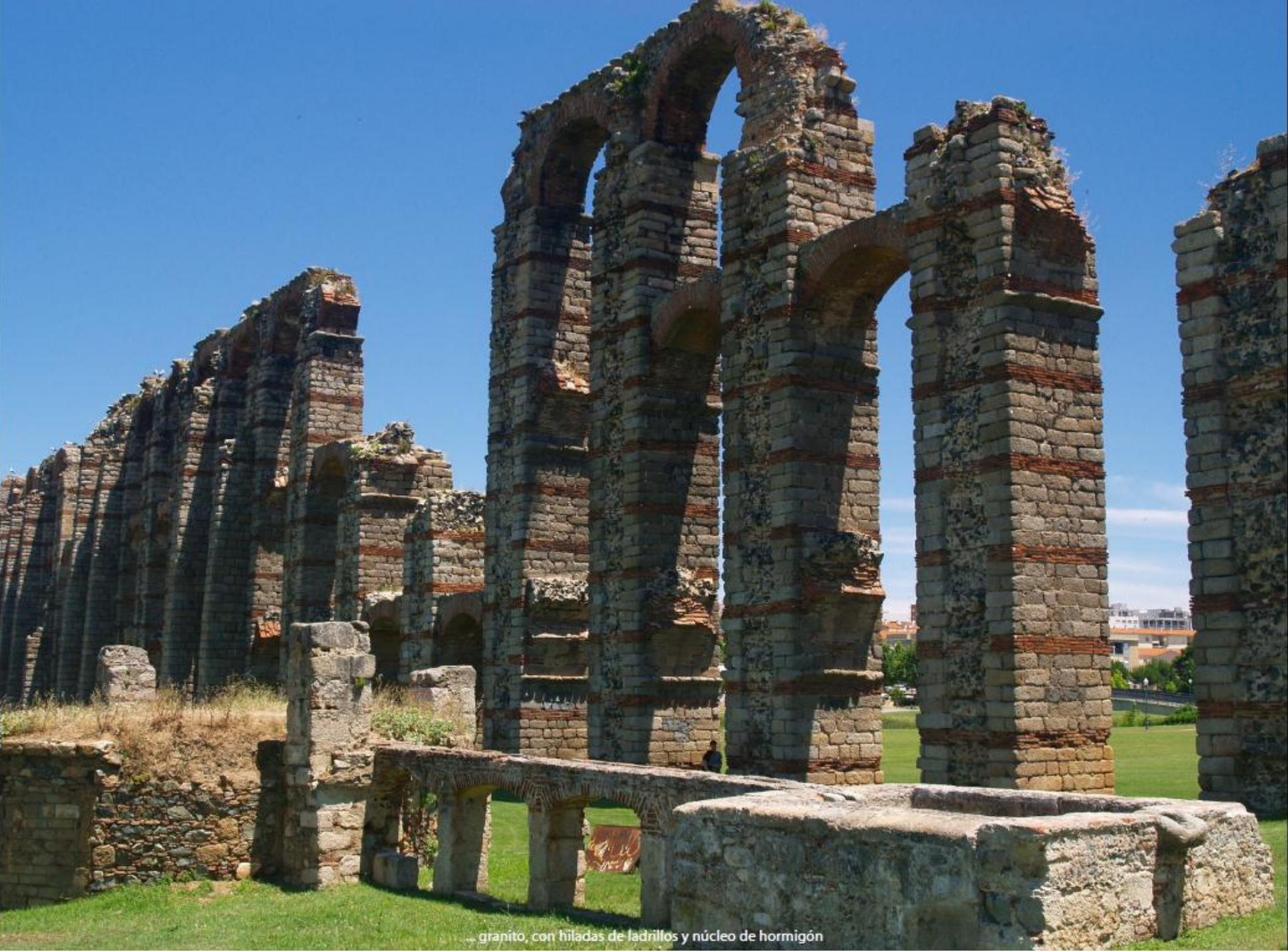
granito, con hiladas de ladrillos y núcleo de hormigón
