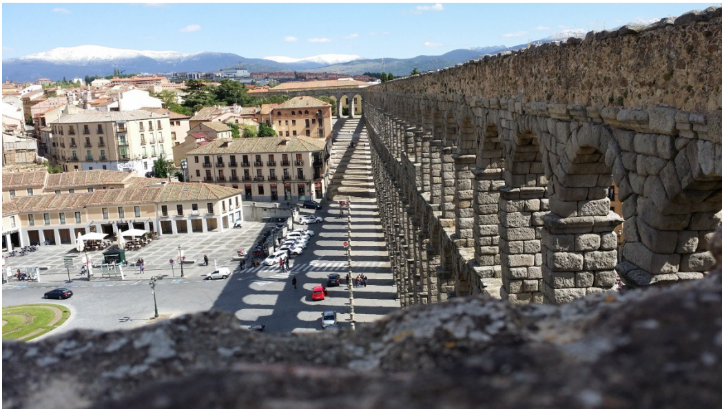
Acueducto con las montañas nevadas al fondo
